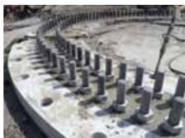
Ancrage dans la roche
