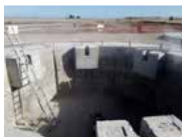
Fondation pour tour en béton
